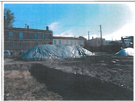
Tas D entièrement criblé, bâché
