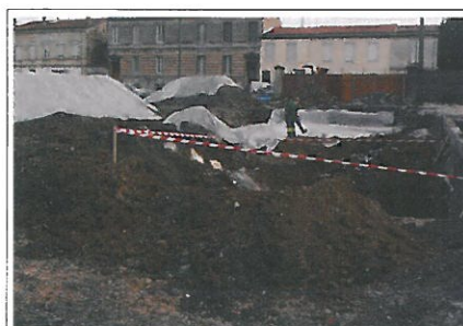
Mise en place de la bâche au droit de la zone de stockage
