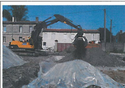
Criblage du Tas A et mise en stock sur la zone prédéfinie
