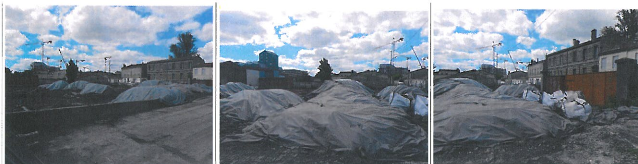
Vues d'ensemble du site à l'arrêt du chantier (photographie du 29/05)
