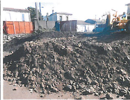
Vue sur la zone remblayée (nord-est du site)
