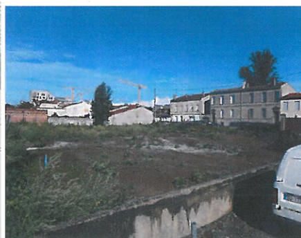
Vue générale sur le site le 17/09/15
