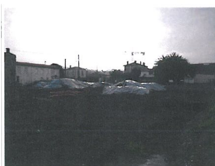
Vue d'ensemble du site à la reprise du chantier
