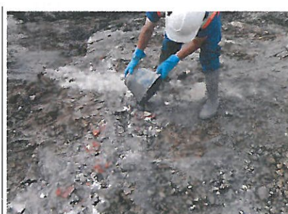
Rebouchage du Pz1 au ciment
