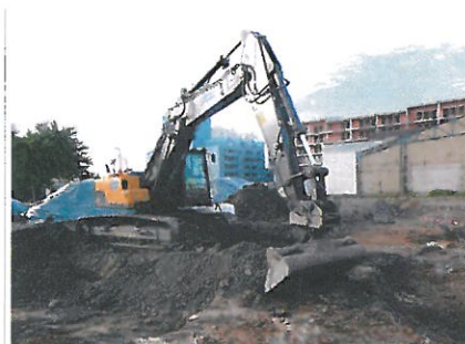
Terrassement de la zone K
